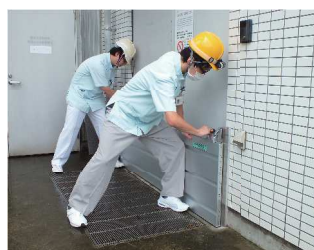
【水害対策 / 止水板の設置風景】
